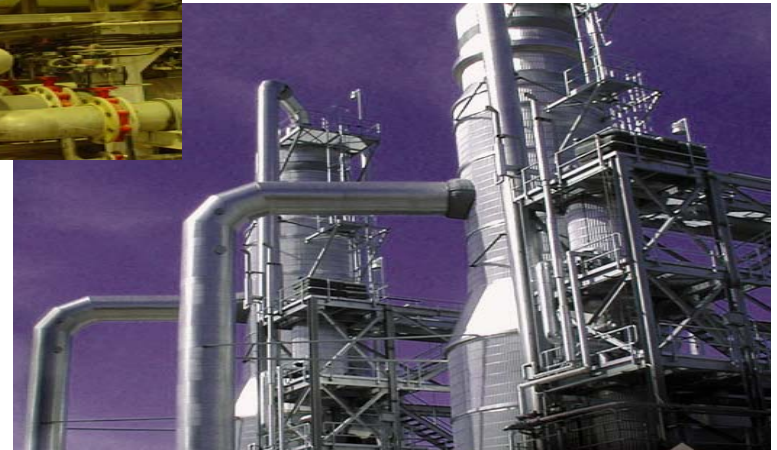
Industrial Reuse - Thermal, RO, UF
